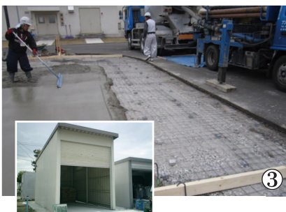
物置設置（自動開閉式）
